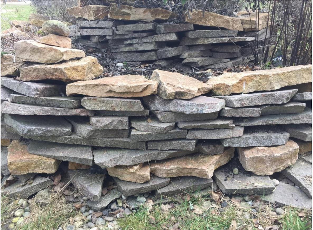
Wenn die erste Steinreihe gelegt ist und die Form der Kräuterspirale feststeht, wird die restliche Fläche mit grobem Schotter aufgefüllt. Nun werden weitere Steine gesetzt und die Fläche nach und nach mit entsprechender Erde aufgefüllt.
