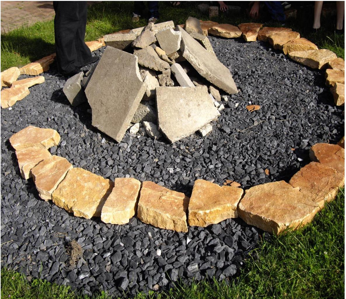
Wenn der Grundriss komplett ausgehoben worden ist, kommt eine Schicht Sand und eine Schicht Schotter darauf. Für die Mitte der Spirale nehmen wir Bauschutt. Hier kann man sehen, wie die erste Schicht der flachen Sandsteine spiralförmig ausgelegt wurde.
