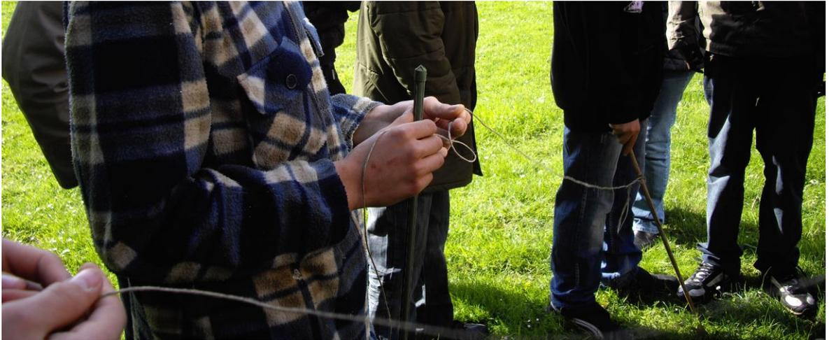
Zunächst wird mit Hilfe eines Stabes und eines Fadens der kreisrunde Grundriss mit Hilfe einer tastbaren Spur aus Sand auf dem Rasen markiert.
